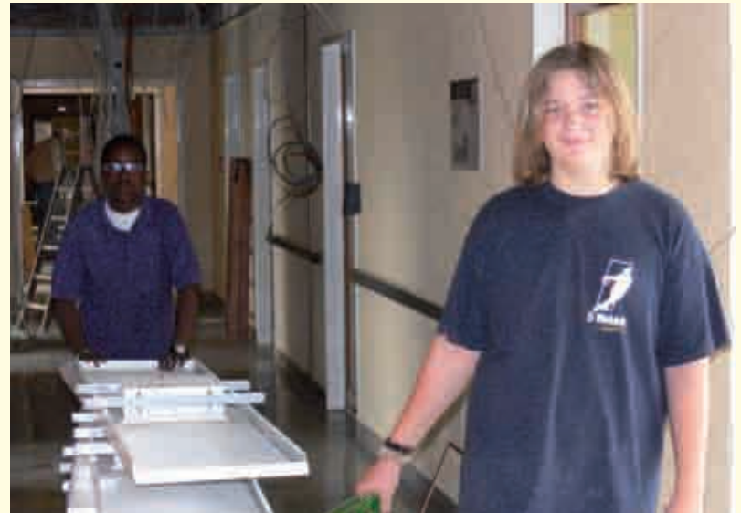
Travaux de recyclage à la Clinique St Louis à Ettelbruck
